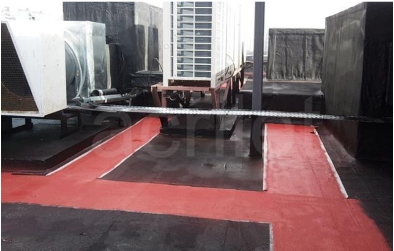
дорожки для эксплуатации оборудования на кровле из жидкой резины
