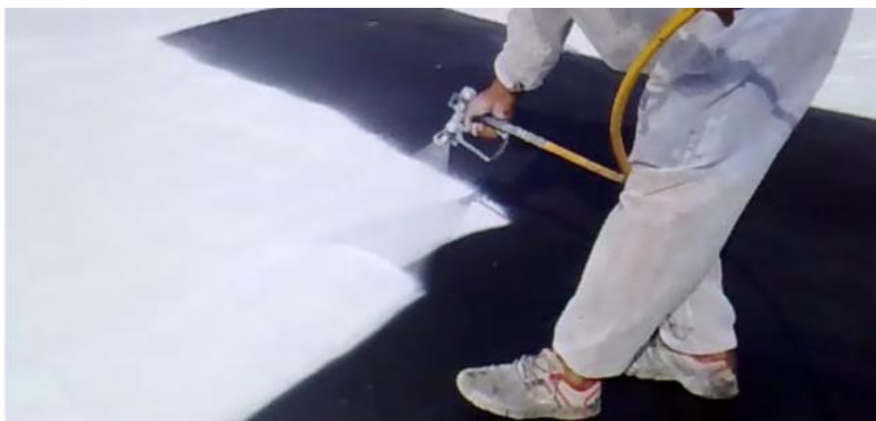
Герметизация фальцев и стыков металлической кровли
