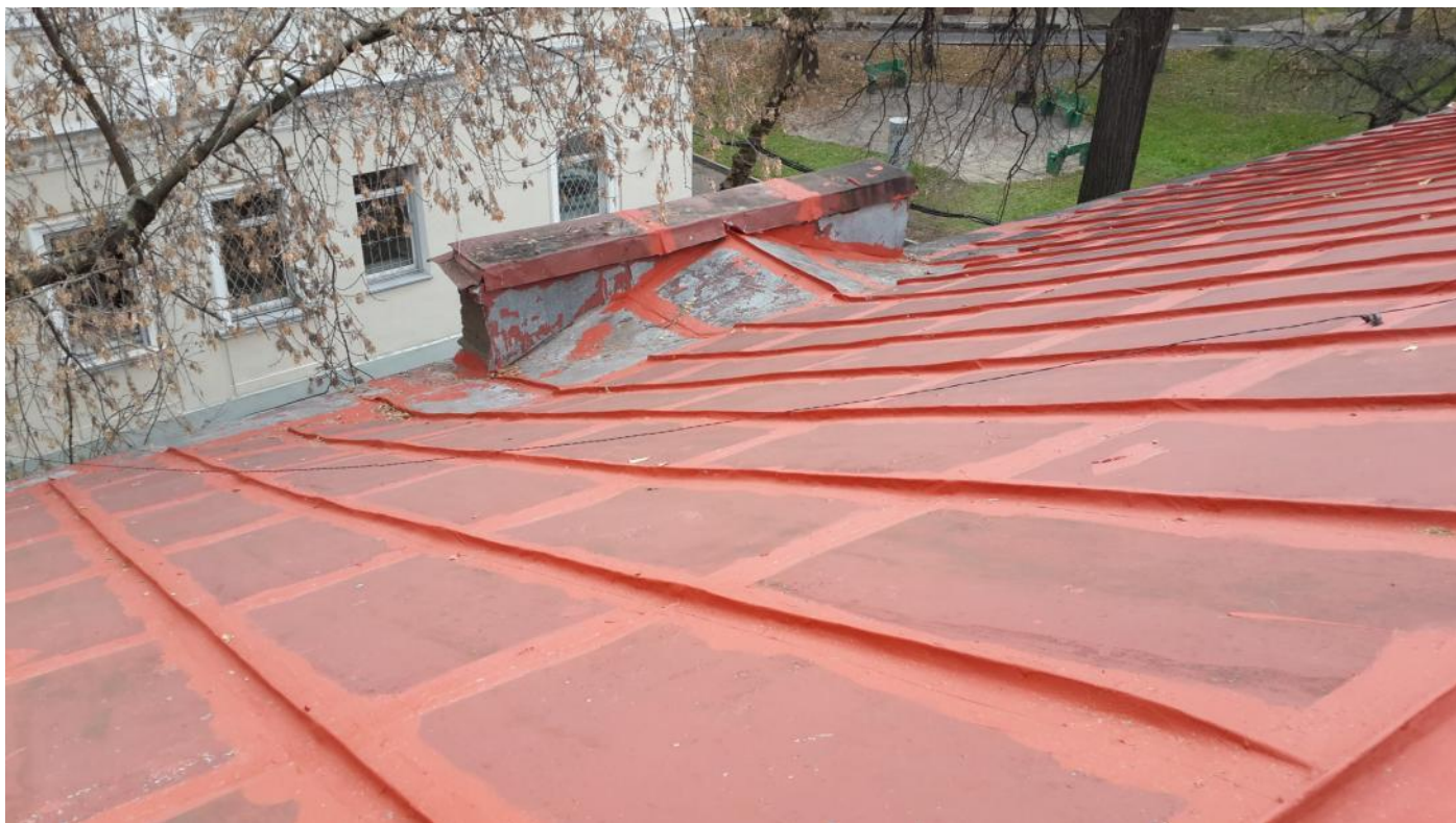
Герметизация фальцев и стыков металлической кровли
