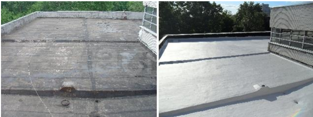
цветная жидкая резина ACRILET 198 - идеальное решение для ремонта мягкой кровли
