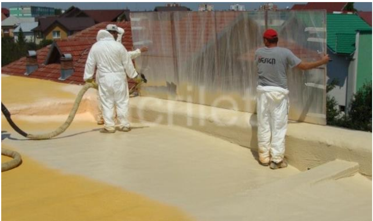
УФ защита пенополиуретаном
