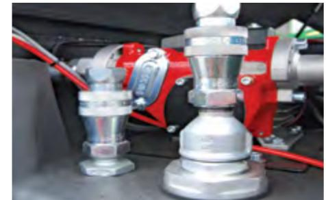
N.2 быстроразъёмных соединения 1/2" для подключения к генераторной установке (прямая + обратная топливная магистраль + всасывающая труба).
