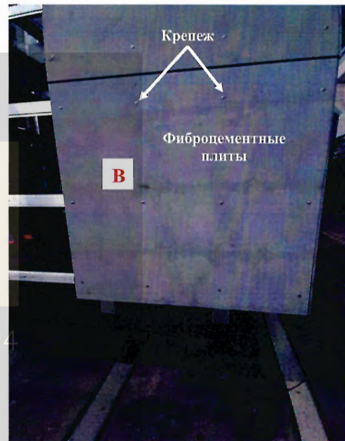
Рисунок 1.12 Фрагменты фасада (сторона «А») в зоне установки облицовки из фиброцементных плит
